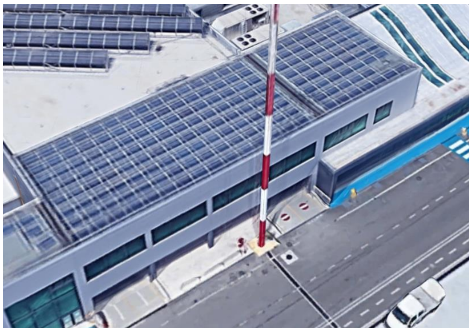
Figura 7-20 Impianto fotovoltaico n.3 posto sulla copertura del nuovo corpo di fabbrica del terminal passeggeri recentemente realizzato
