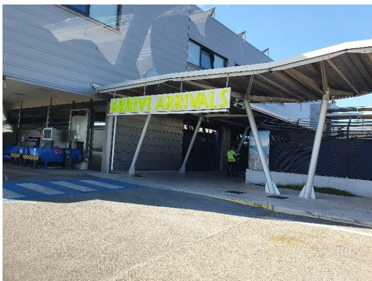
Figura 15-7 Tipologia di copertura metallica da utilizzare per collegamento pedonale tra la stazione ferroviaria e l'aerostazione
