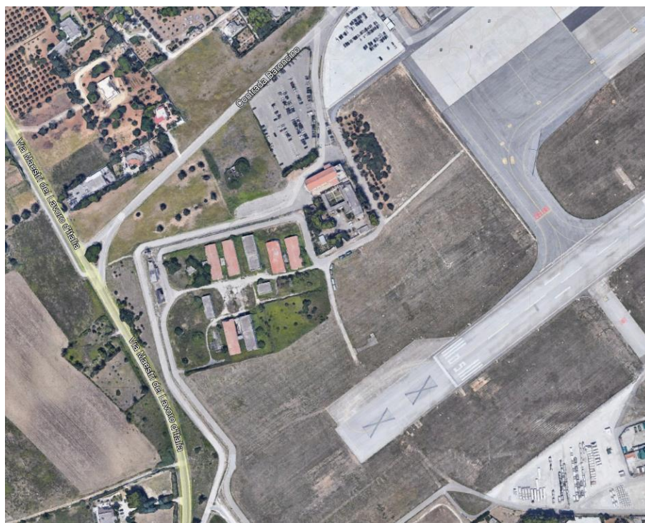
Figura 15-2 Area per la sosta e ricovero dei mezzi rampa
