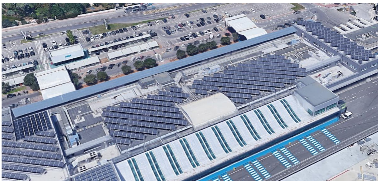
Figura 7-18 Impianto fotovoltaico n.1 posto sulla copertura del terminal passeggeri
